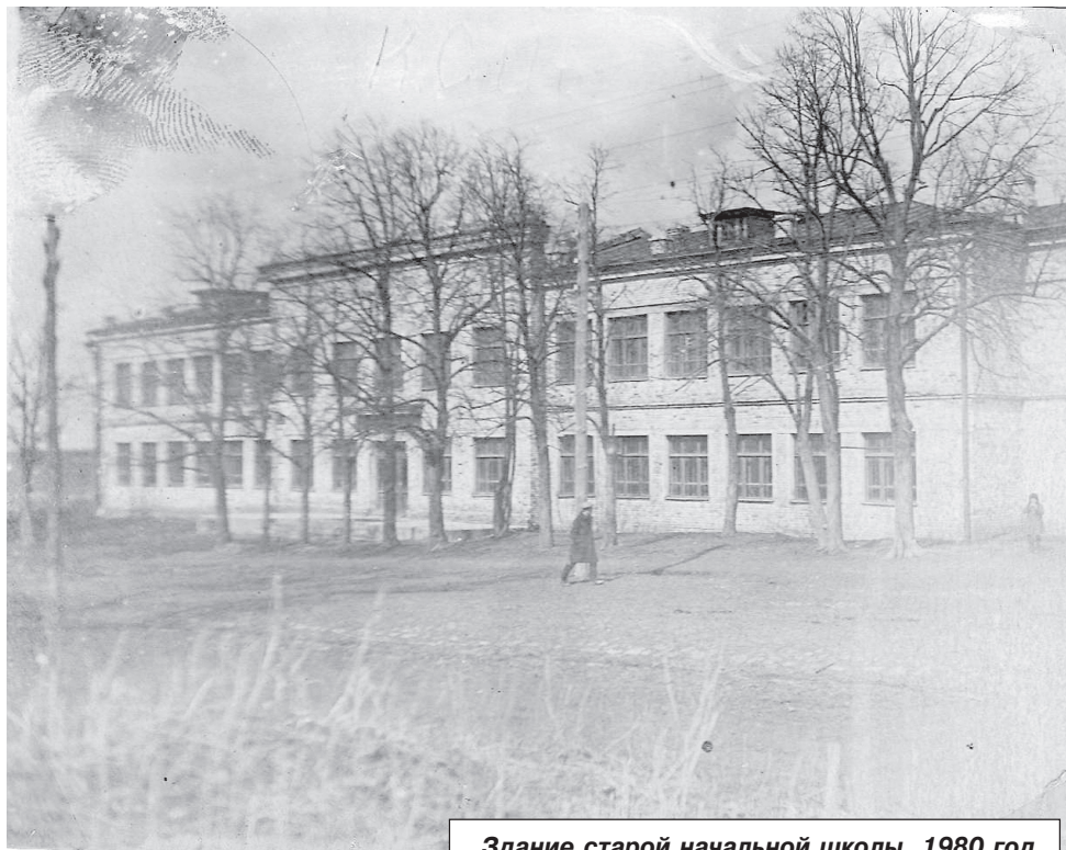
Здание старой начальной школы, 1980 год.
